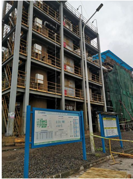
图 2 现有的焚烧尾气处理装置
